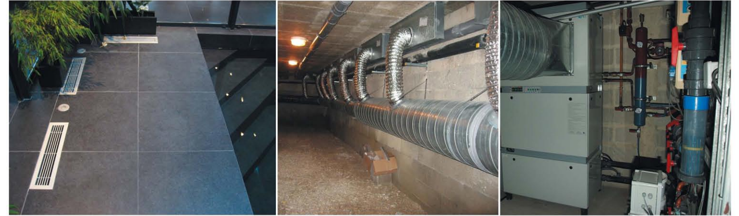
Centrale de déshumidification avec réseau de gaine
